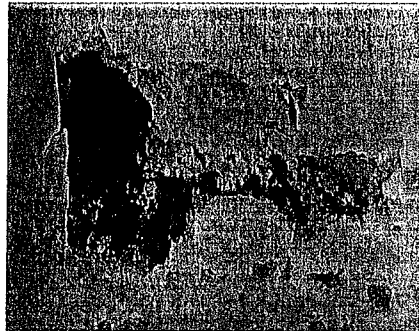
東3樓樓梯間牆面鋼筋外漏
